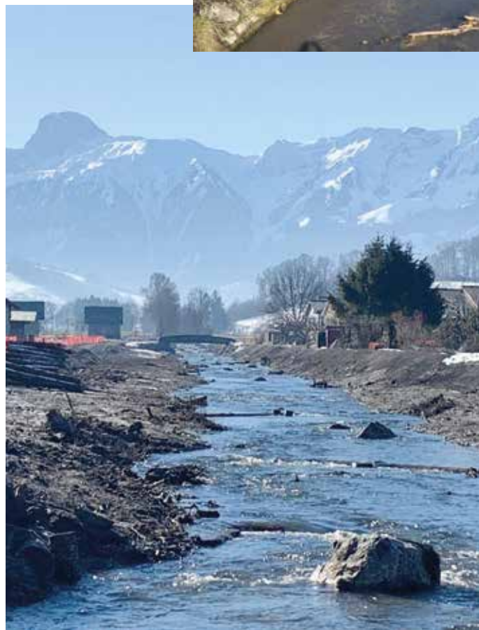
Gürbe nach Hochwasserschutzmassnahmen La Gürbe après les travaux de protection contre les crues
