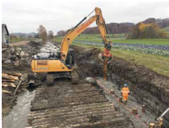
Bauarbeiten neuer Uferverbau Travaux d'endiguement
