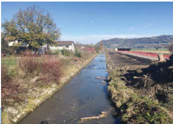
Gürbe vor Hochwasserschutzmassnahmen La Gürbe avant les travaux de protection contre les crues
